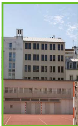
À gauche : vue sur le bâtiment depuis la cour intérieure
